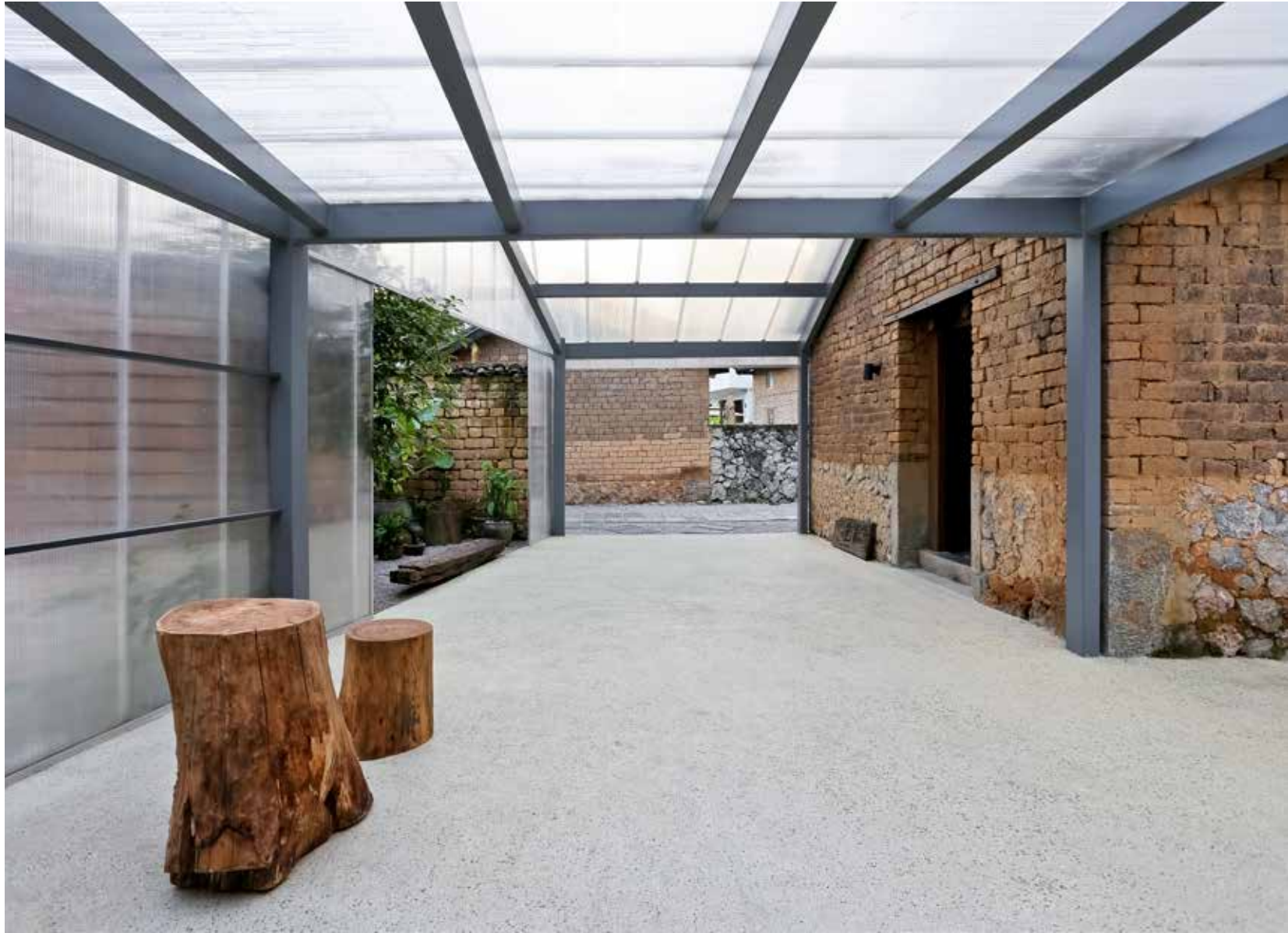
本页，上图：酒店入口。 下图及对页：客房庭院，可以看到新 加的钢结构系统与老农宅的泥砖墙 在材料上形成一种对比和对话 • This page: above, the entrance of hotel.
